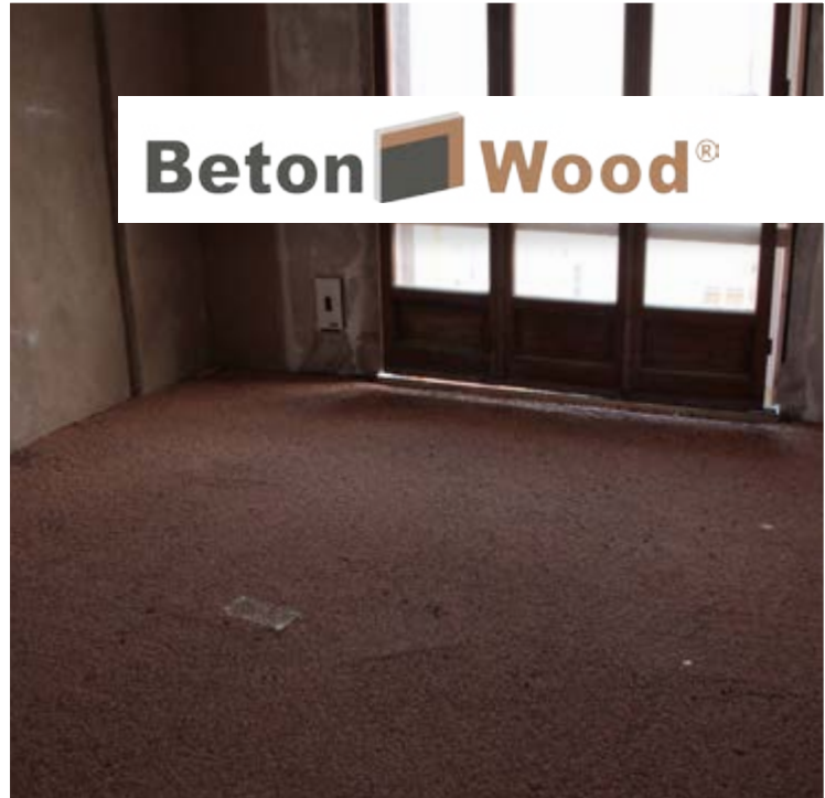
Staggiatura del granulato tipo Cork Granules nel sistema radiante sopraelevato Betonradiant®
