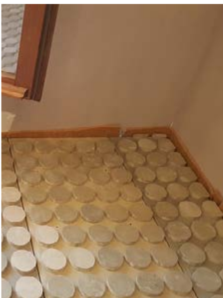
Disposizione giunti di dilatazione al di sotto di porte battenti ed in corrispondenza del passaggio tra una stanza e l'altra.
